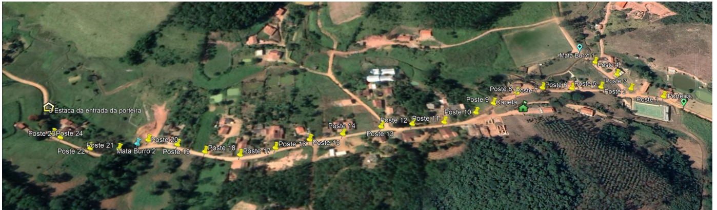
Foto 01 – Localização do calçamento
